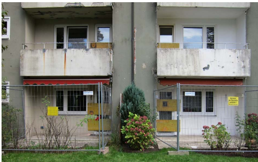
Abbildung 1: Balkonreparatur, © Georgia Diesener
